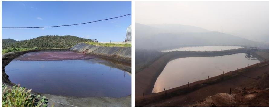
Figura 25. Lagoas de armazenamento de águas-ruças a céu aberto na indústria extratora sujeitas a processos de fotólise, evaporação e decantação, durante meses. Fonte: Costa, S. (2023).
